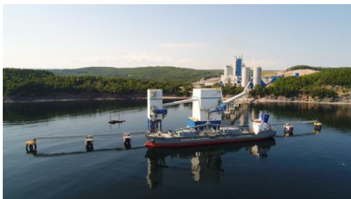
Cement Carrier voorzien van cement systeem van Van Aalst Marine & Offshore B.V.
